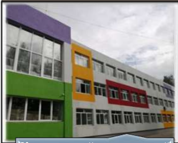
Комплексный капитальный ремонт школы № 10 82 494,9
